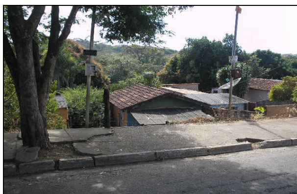
Figura 4 - Ocupação de vertente sem controle da administração pública ou órgão competente. Foto CCSJ/2006
